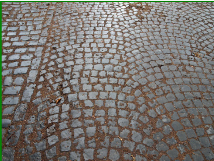
Segmentbogen-Kopfsteinpflaster aus Basalt in Hann. Münden „vor der Bahn“. Links schließt das großformatige Reihenpflaster im Bereich der einstigen Schüttgutrutsche an.
