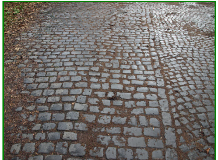
Großformatiges Reihenpflaster im Bereich der ehemaligen Schüttgutrutsche in Hann. Münden „vor der Bahn“. Auch in den Mündener Ladestraßen und -rampen wurde entsprechendes Pflaster verarbeitet.
