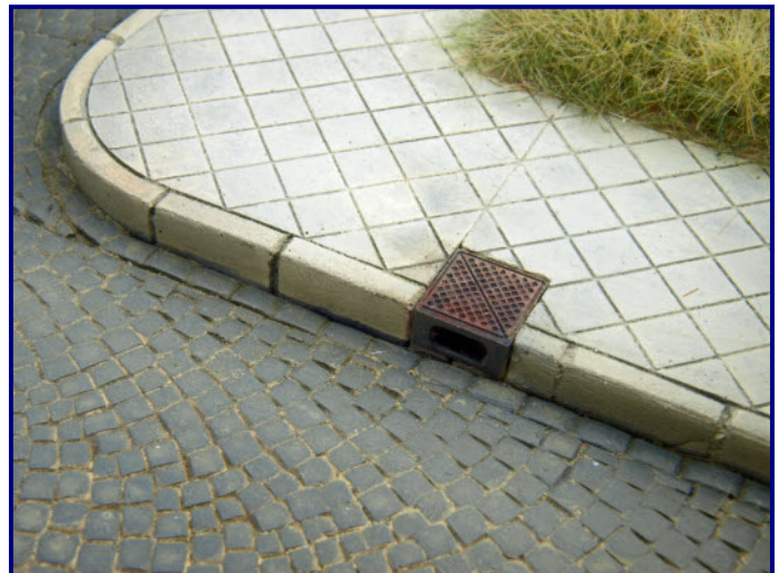
Bürgersteigecke mit dem Borsteingully von Wenz
