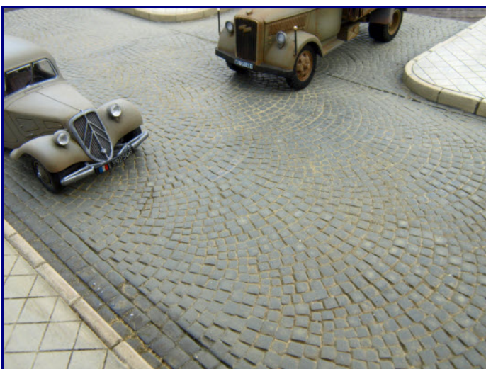
Stößenkreuzung aus Segmentbogenpflaster
