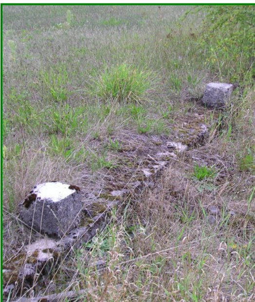
Reste der ehemaligen Ladestraßenkante von Oberscheden mit würfelförmigen Prallsteinen.
